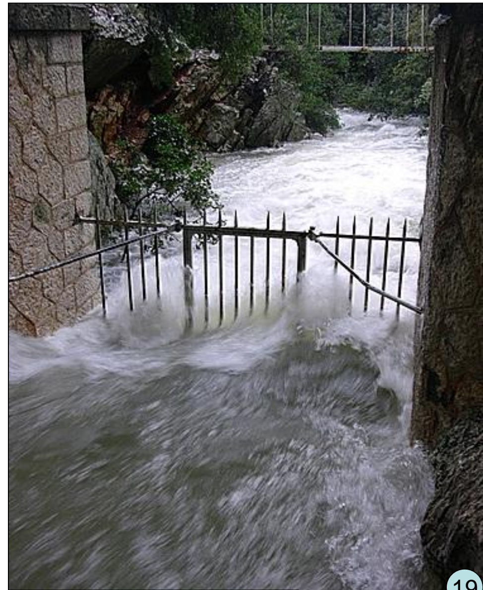
Le Revest les Eaux Résurgence du Ragas en action
